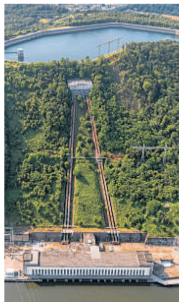
RWE will den gesamten Mittelblock am Koepchenwerk abreißen. FOTO: H. BLOSSEY
