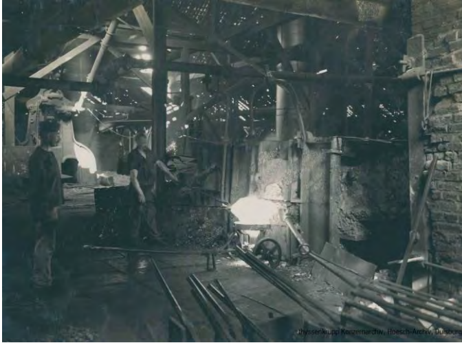
Arbeit der Puddler (Quelle: thyssenkrupp Konzernarchiv, Hoesch-Archiv, Duisburg) links das „Zängen, rechts der Abtransport per Schubkarre
