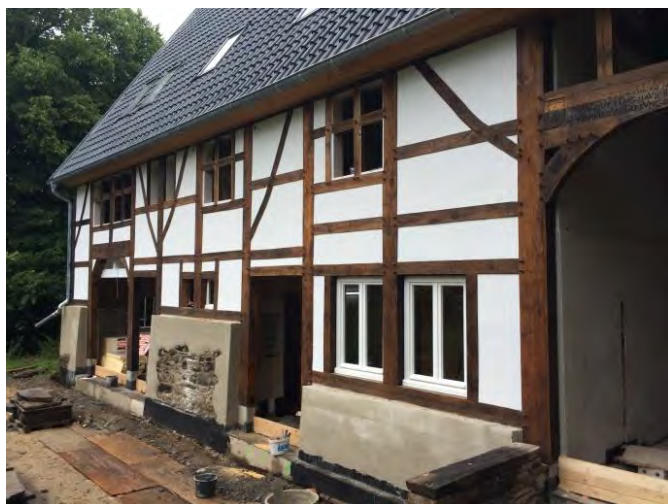
Ökonomiegebäude auf Gut Harkorten, Hagen-Haspe während der Renovierung Oktober 2015 (© BAV GmbH Foto: Werner Schliepkorte)
